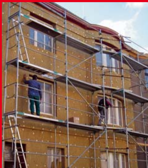
Zateplování fasády materiálem Frontrock MAX E
