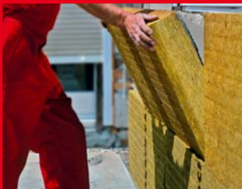
Postup montáže je obdobný s ostatními běžnými systémy minerálního zateplení ETICS
