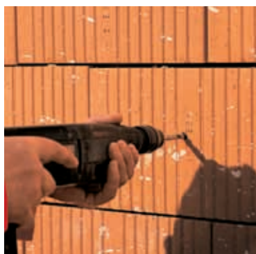
1. Vrtání otvorů pro hmoždinky kotev (obr. 14)
