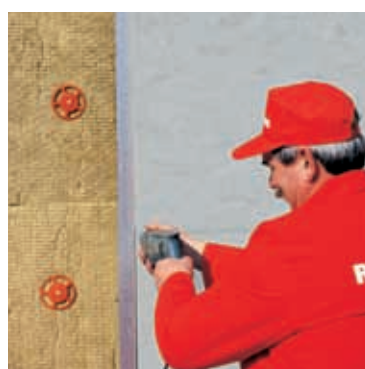
8. Montáž obkladu fasády (obr. 21)
