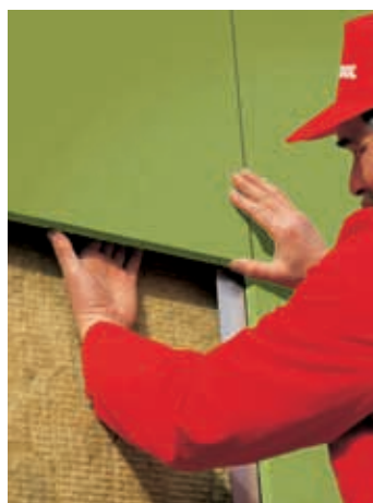
Provětrávaný zateplovací systém (obr. 10)
