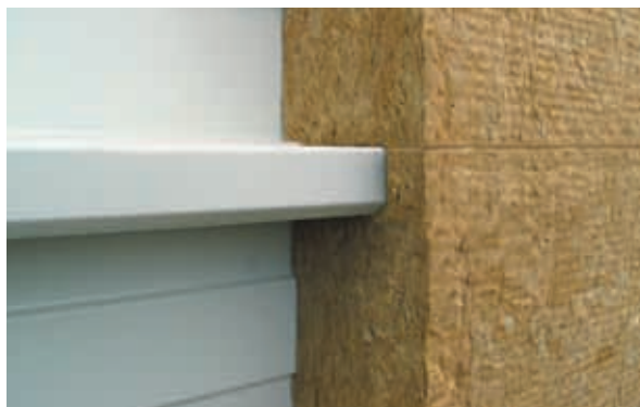
Izolační deska Airrock ND přesahuje kazety o 40 mm (obr. 23)
