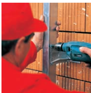
3. Montáž nosných profilů pro obklad (obr. 16)
