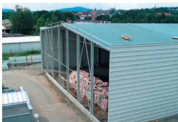
Montáž kazet na sloupy (obr. 27)
