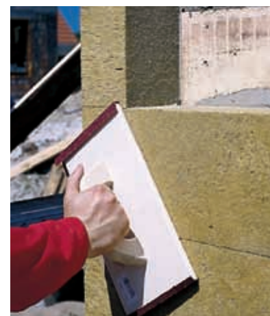
Kontaktní zateplovací systém (obr. 11)
