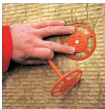
7. Kotvení izolace pomocí např. držáků izolace (obr. 20)
