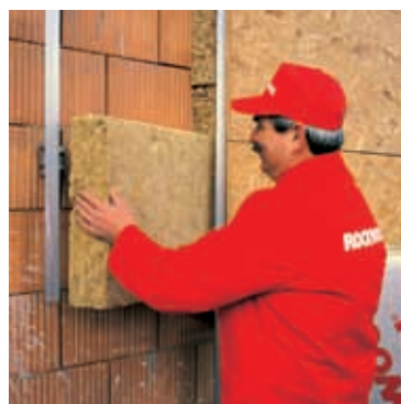
5. Vkládání izolace mezi nosné profily fasády (obr. 18)
