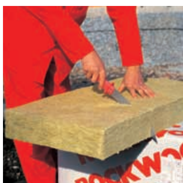
4. Řezání izolace – izolaci lze řezat speciálním nožem, případně nožem se zuby (obr. 17)
