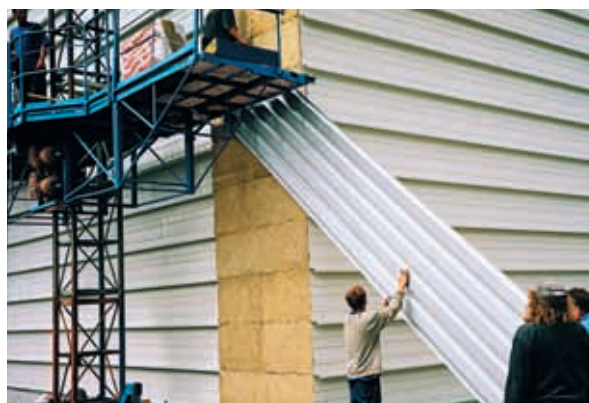
Přesun obkladového plechu na fasádu (obr. 28)
